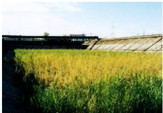
Abb. 2: Constructed Wetland zur Behandlung von Gülle, Agrar- und Gewerbepark Delitzsch
