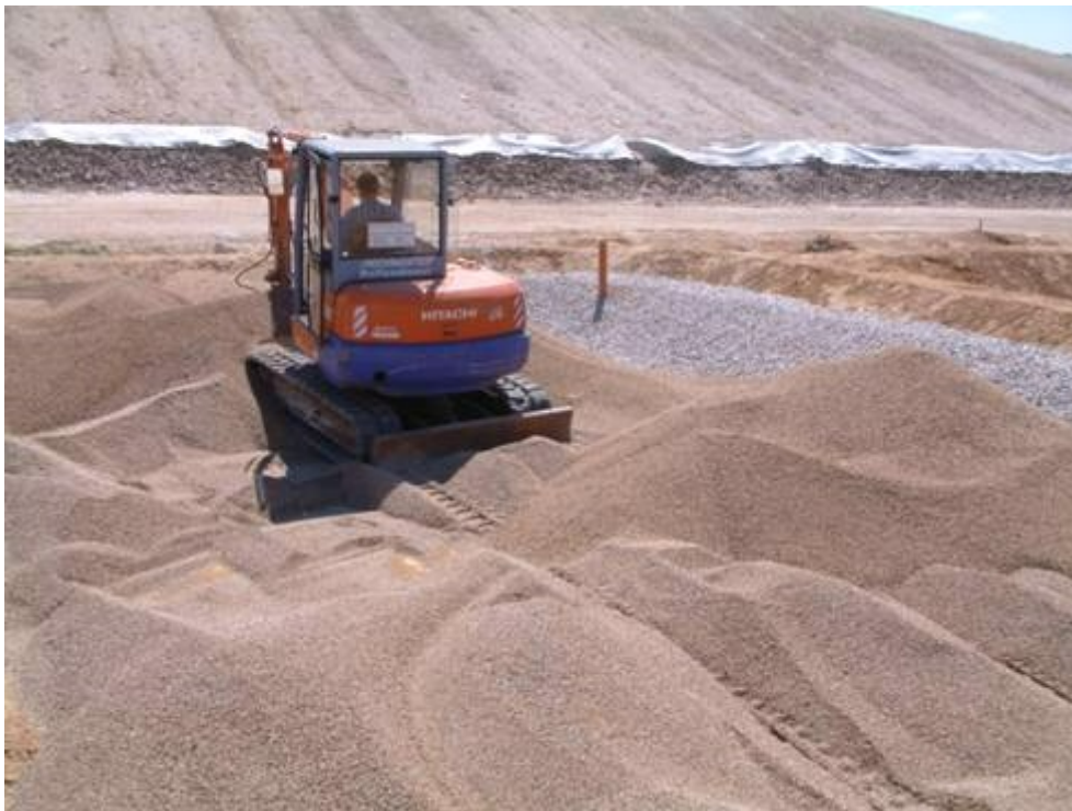
Abb.: Befüllung des Wetlands mit Kies, im Hintergrund ist die Deponie erkennbar
