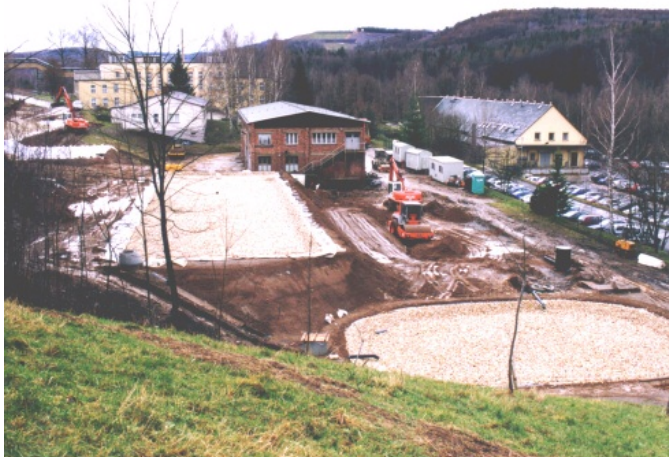
Abb. 1: Becken 4, im Vordergrund der Schönungs- teich während der Bauphase
